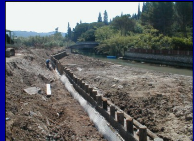
Palificata e gabbioni cilindrici
