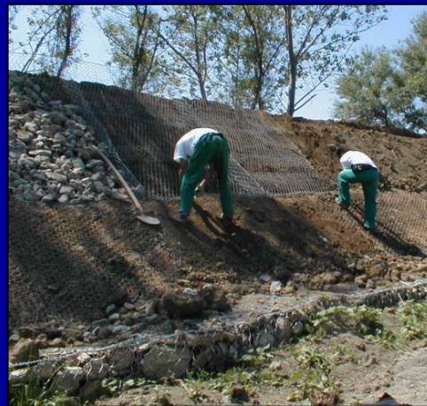
Materassi spondali rinverditi
